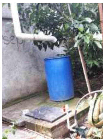
Figura 12. El tubo de llegada se desensambla de forma manual y se desvía al tanque de primeras aguas.
