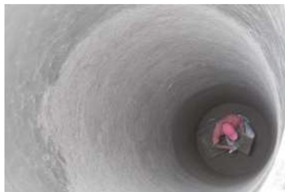
Figura 7. Detalle del colado de la losa inferior.
