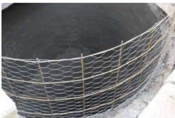
Figura 6. Detalles del terminado interior.
