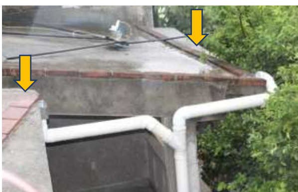
Figura 10. Colocación de tubería de PVC con diámetro de 4".
