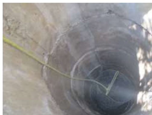
Figura 5. Colocación de las mallas dentro del pozo.
