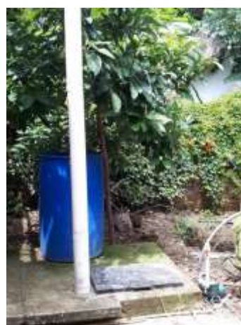
Figura 13. Después de las primeras lluvias se coloca el tubo de forma correcta.
