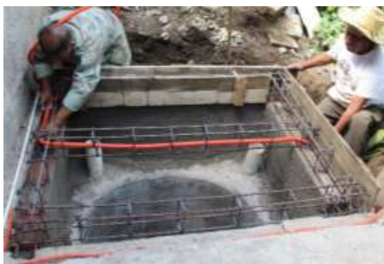
Figura 8. Detalle de la colocación de los tubos de PVC y ductos para la instalación de la bomba.
