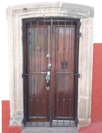
Fig. 9. Fachada de vivienda, ubicada en Calle Patrocinio. Foto Cynthia Flores, 2019.
