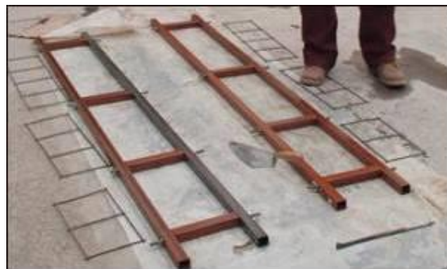
Figuras 4 a 7. Detalles de los moldes y armados.
