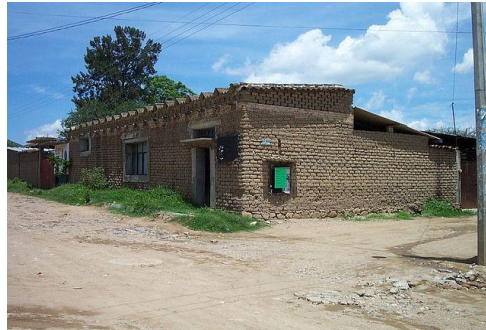
Figura 3. Vivienda de adobe
