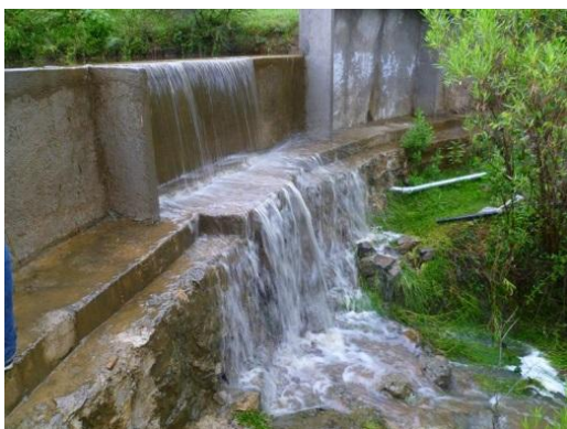
Figura 11. Aspecto de la represa llena, con el vertedor de demasías en funcionamiento.
