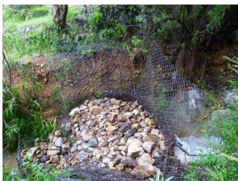
Figura 9. Colocación de malla ciclón aguas arriba, previo con agregado pétreo para para formar gaviones para la retención de basura producto del arrastre por la lluvia.
