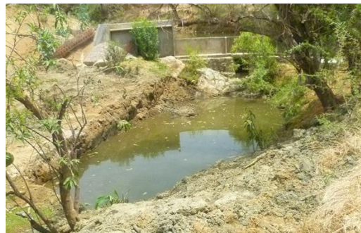
Figura 14. Poza construido aguas abajo y recargado por medio de la filtración lo cual se mantiene constante durante el periodo de estiaje.
