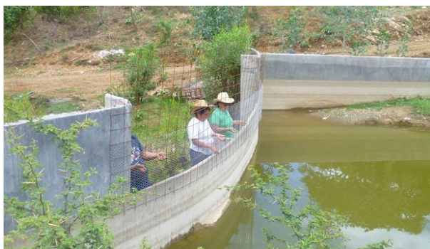
Figura 12. Vertedor de demasías de la represa colocado una malla electrosoldada y malla de gallinero para detener a los alevines y peces de mayor tamaño en alguna avenida extraordinaria.
