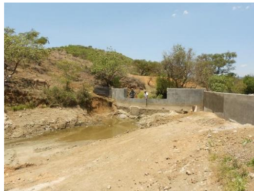
Figura 6. Muro terminado de la represa, extremo lateral ya delimitado conservando el nivel del vertedor de demasías final y dragado del vaso de almacenamiento.
