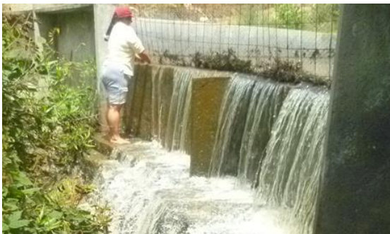
Figura 13. Malla en funcionamiento donde se aprecia la retención de basura no retenida aguas arriba y la retención de los alevines por la avenida.
