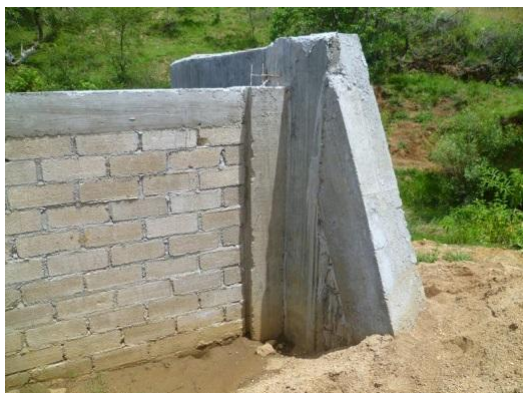
Figura 7. Refuerzo lateral por falta de empotramiento natural (ladera o cerro) de la margen derecha.
