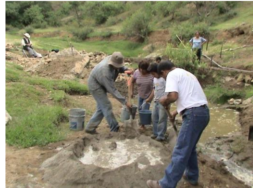
Figura 2. Mezcla de mortero para el junteo de piedra en la cimentación.
