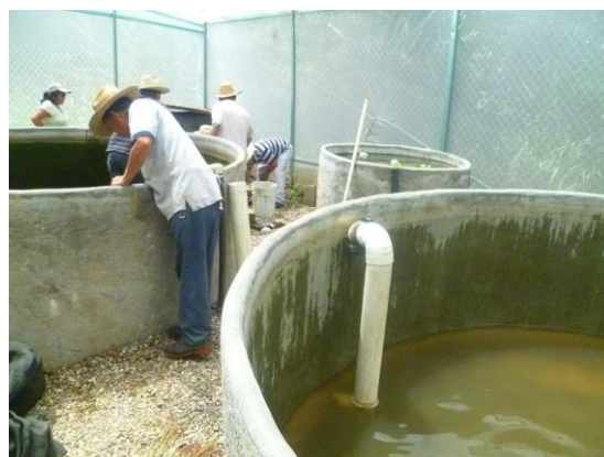
Figura 17. Limpieza de tanque en forma periódica para el desalojo de lodos y excretas al terreno de cultivo.
