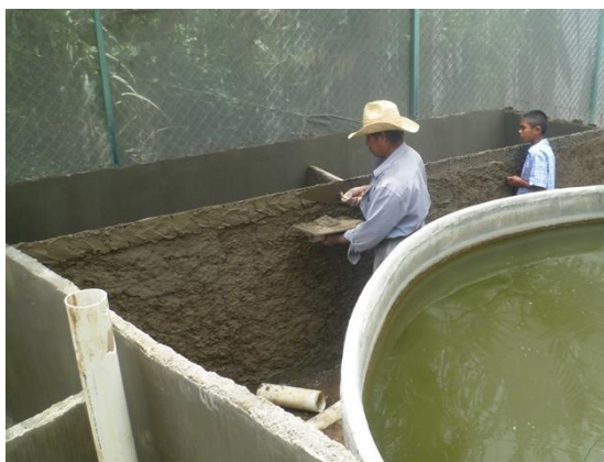
Figura 16. Proceso constructivo de los estanques circulares y rectangulares.
