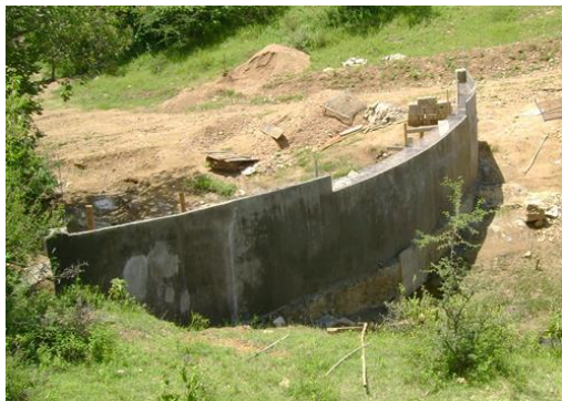
Figura 5. Muro concluido antes de delimitar la parte lateral y recortar el muro para formar el vertedor de demasías.
